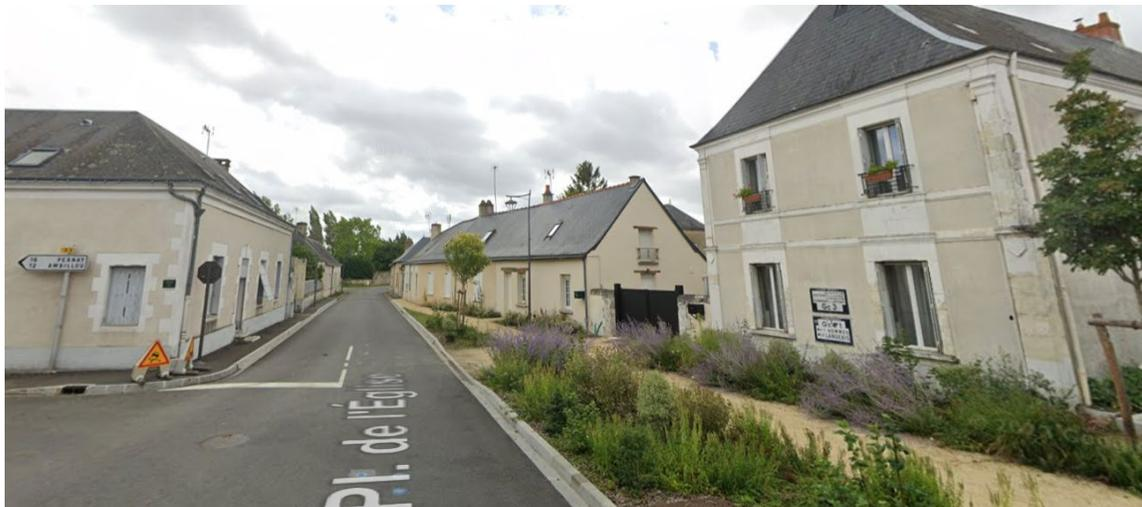
*L'habitat ancien est de volumétrie R+C à R+2+C. Il est groupé et aligné sur la rue. Les façades sont en moellons calcaires et en tuffeau. La toiture est en ardoise.*
